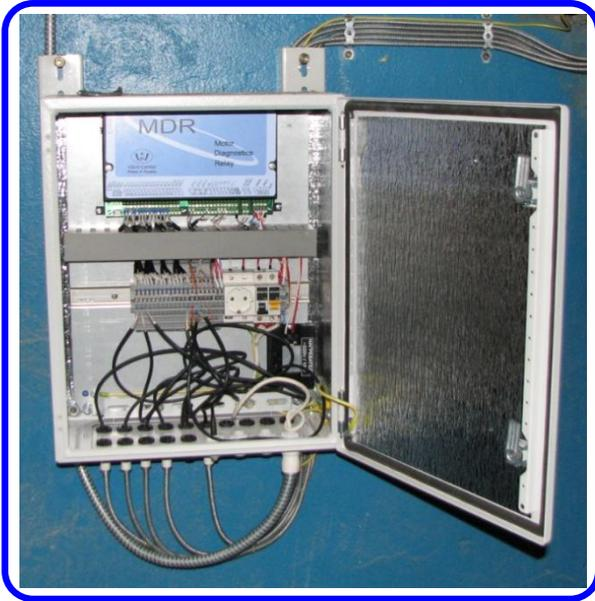
Система «MDR» для мониторинга состояния изоляции монтируется рядом с контролируемым электродвигателем, обычно с использованием монтажного шкафа.
